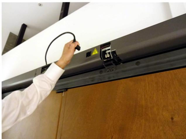
① 上部フレーム中央部のコンセントプラグを抜き、電源を切ります。
