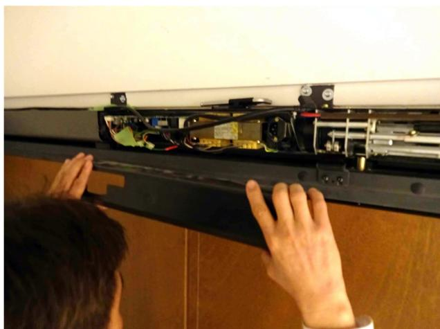
③ さらにその内部の、回路部分に付けられているカバーも同様に、ネジを抜き取って取外します。
