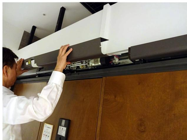
② 中央部カバーの左右にあるネジを抜き、これを取外します。
