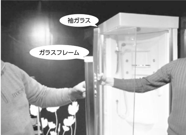
②下写真の通り、ガラスフレームを袖ガラスのフレームに差し込みます。
