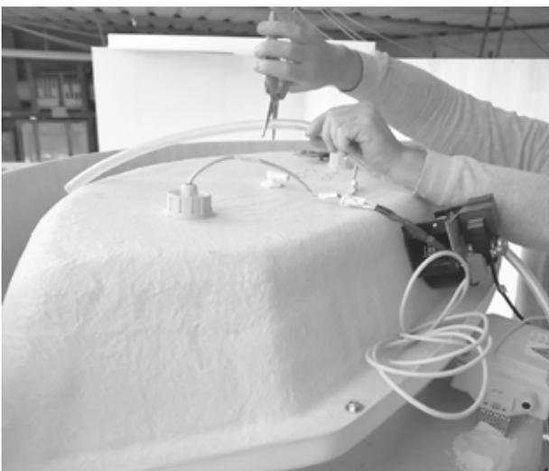
③ホースにホース締め付け具（プラスチック製）を通した状態で、ホースをレインシャワー給水口に差し込み、接続部分をホース締め付け具（プライヤーなど）で締め付けます。
