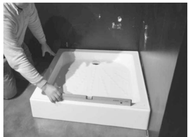
③水平でない場合、シャワートレイ裏面のアジャスターを回転させ、水平になるように調整していきます。
