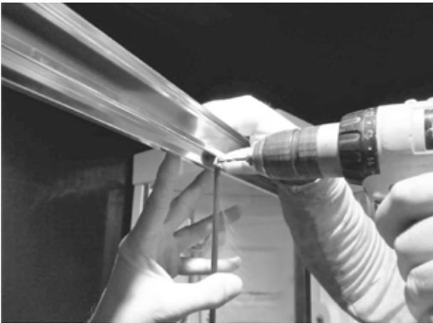
⑦ ハンドドライバードリルネジをねじり込み、袖ガラスをガラスフレームに固定します。
