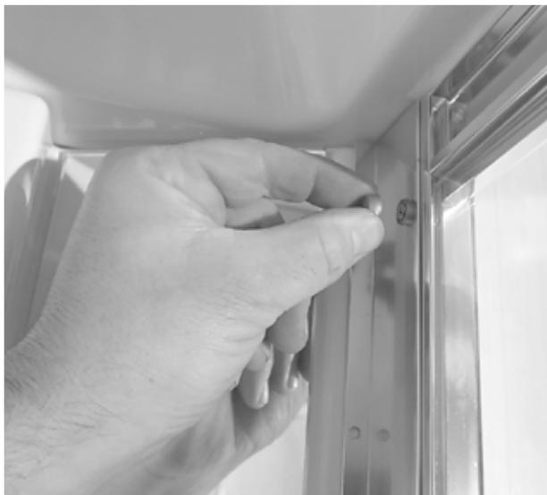
⑤下側も同じ手順で、『下から50mm/内側から15mm程度』の場所にドリルで穴を開け、C型フレームと袖ガラスをネジ固定します。
