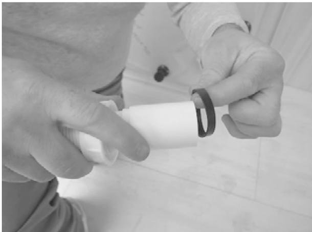
③シャワートレイ裏側の排水口に、ゴムリングを取付けた排水ホースの口を接続します。
