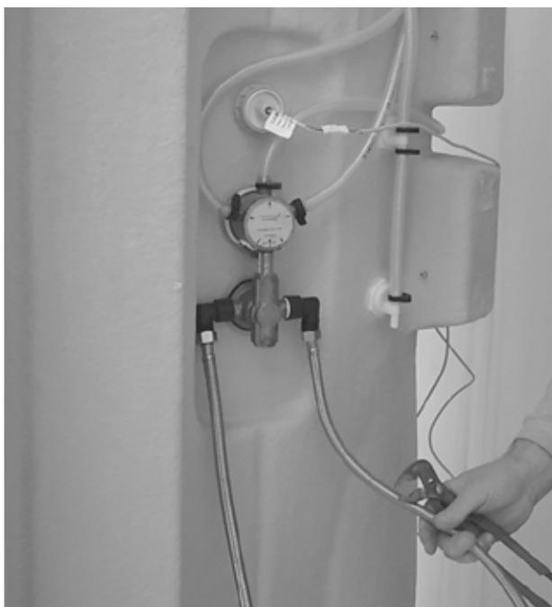
③給水ホース2本の反対側の端を、建物壁面の給水口（湯水共）に接続します。
