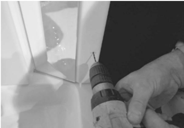
⑤サイドC型フレームの中央部にシリコンを塗布し、先程開けた穴にネジ穴をあわせて接着します。
