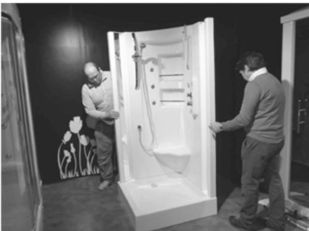
②鉛筆でマークしたら一旦L型壁をどかし、接続ライン（接続後見えなくなる部分）にシリコンを打ちます。
