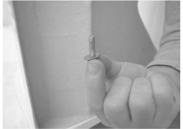
④シャワーウォールの穴の上から別のワッシャー1枚とナットを差し込み、接続していきます。(6カ所)
