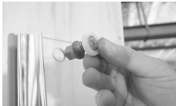
⑤いま差し込んだローラーを、ドアパネルを挟み込む要領で裏側からローラー固定具を押し込みます。
