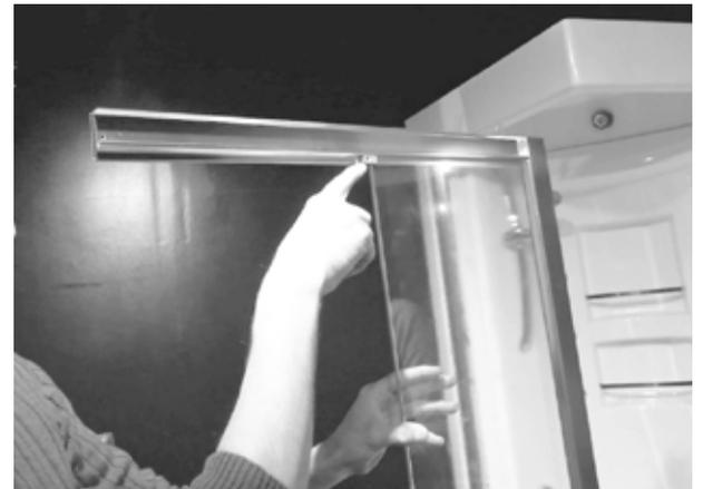
⑥ ガラス固定具のネジ穴がある箇所にも M 3 ドリルを差し込んでガラスフレームに穴を開けます。
