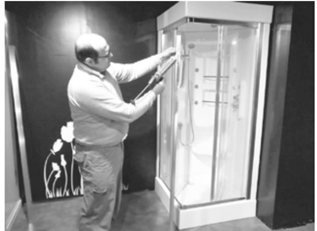
②本体壁面と建物壁面の隙間に、再度モールディングを取付けます。
