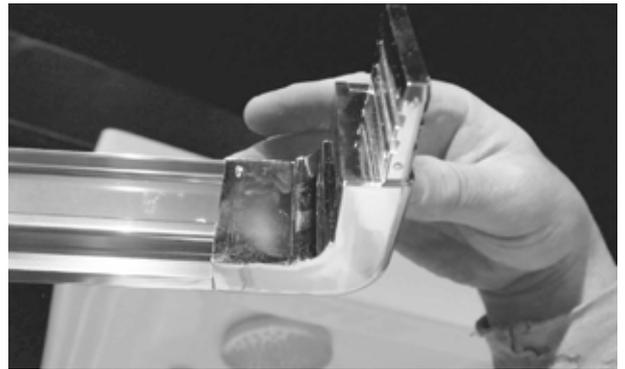
⑪ 鍋ドリルネジで L 型接続具をガラスフレームに固定します。
