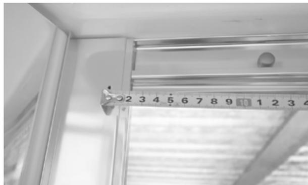
③付属のサラM 3.5x12mmドリルネジにキャップ留めワッシャーを差し込み、さきほど開けたネジ穴に差し込んでドアフレームを固定します。
