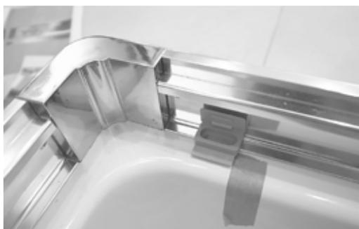
④取付位置が確定したら、ロックワッシャーと専用ドリルネジで扉ストッパーを固定します。
