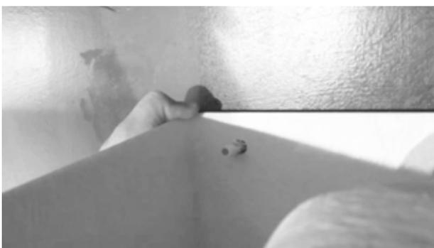
④木ネジにワッシャーを差し込み、壁面に打ち込んでいきます。
