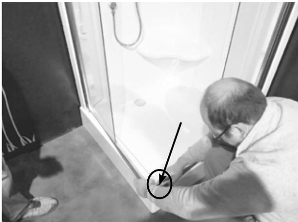
⑰上部分のL型接続具をガラスフレームに差し込んで接続した後、銅ドリルネジでこれらを完全に固定します。
