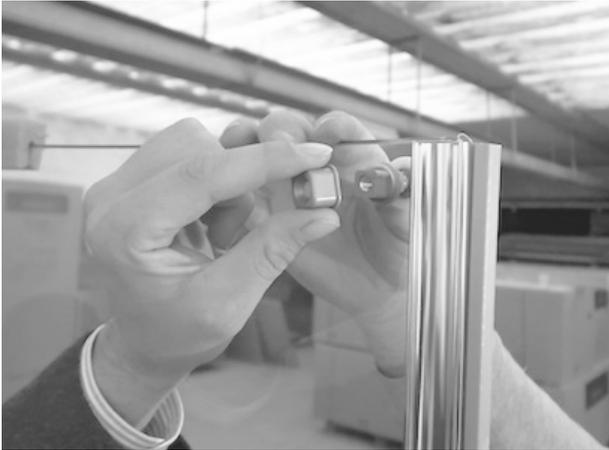
⑥サラ M 6x 8 六角ネジをローラー固定具に差し込み、付属の六角レンチで”軽く”仮固定します。
