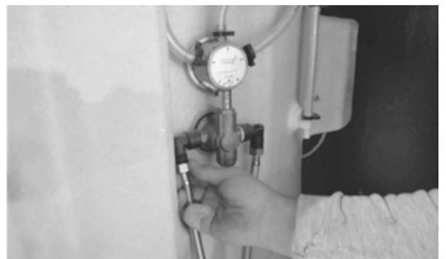
②接続したら、プライヤーでしっかり締め付けてください。
