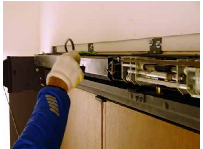
② 安全のため、必ず電源を外してください。
