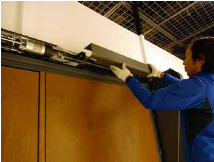
① 本体上部の駆動装置のカバーを外します。
