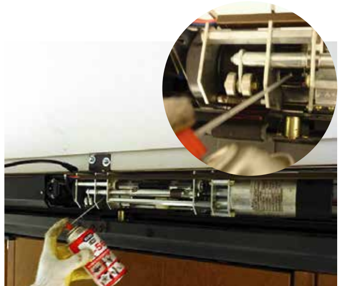
⑫ 次に中央のベルト駆動用連結ギヤ部分に潤滑剤を塗布します。
